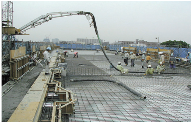
⑨コンクリート打設
