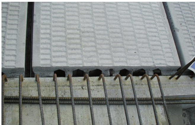
⑭壁コンクリート打設穴(壁筋貫通穴)
