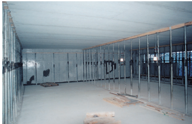
⑩養生期間中の室内
