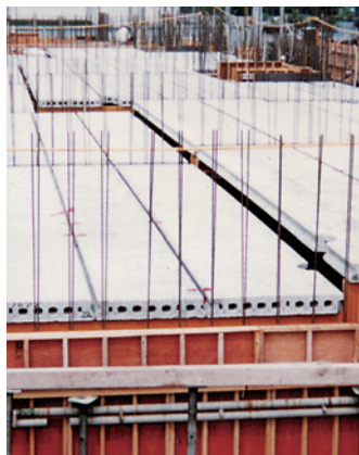
⑯段差部分
