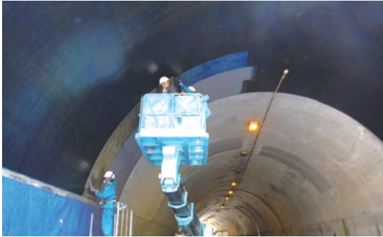
炭素繊維シート工法
