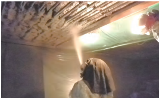
下面増厚工法
