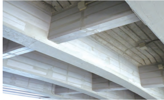
電気防食工法
