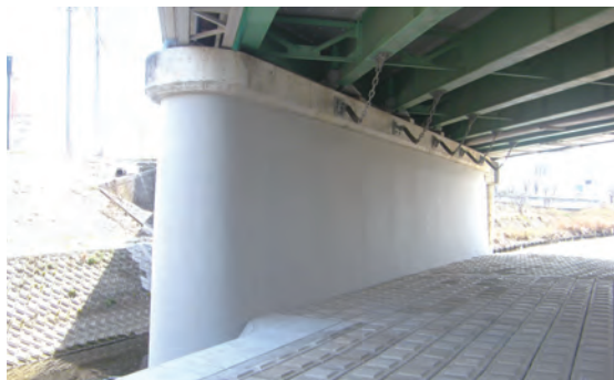
橋脚耐震補強工法
