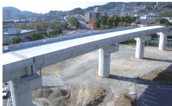
ポストテンション連結T桁橋
