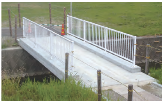
BTスラブ（簡易橋）
