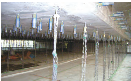
ひび割れ注入工法
