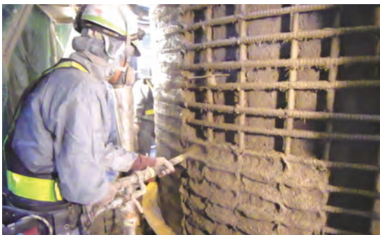
橋脚耐震補強工法
