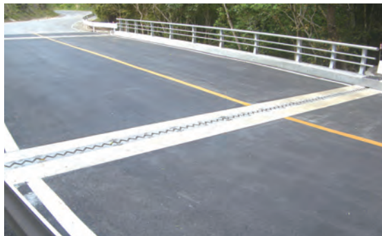
伸縮装置取替え
